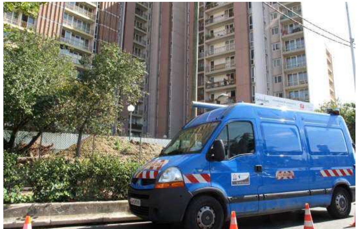
GENNEVILLIERS, HIER. Les équipes de GRDF sont intervenues en urgence dans cette résidence à cause d'une fuite de gaz qui pourrait être due à un mouvement du sol. Les soixante personnes évacuées ont pu réintégrer leur logement vers 12 h 30. (LP/M.P.)
